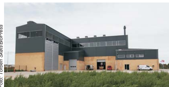
Sindals nye kraftvarmeværk.
