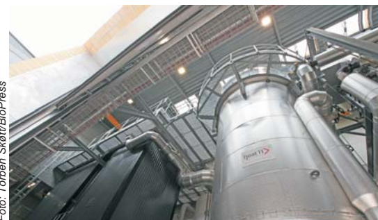
Et kik ind i maskinhallen. Forgasserovnen er de to sorte tårne til venstre.
