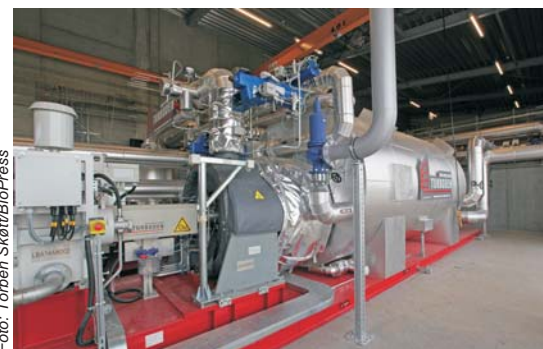
ORC-anlægget fra italienske Turboden kan levere 800 kW el.
