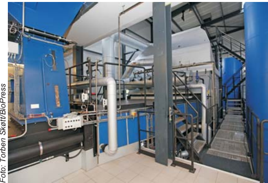
Et kig ind i maskinhallen med det nederste af ovnen til venstre på billedet. Bagerst til højre ses kedlen.
