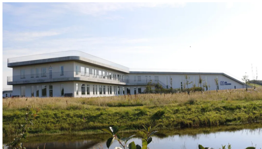
Går alt efter planen vil et nyt pyrolyseanlæg være klar til brug hos Din Forsyning i 2026. | Foto: Din Forsyning/pr
