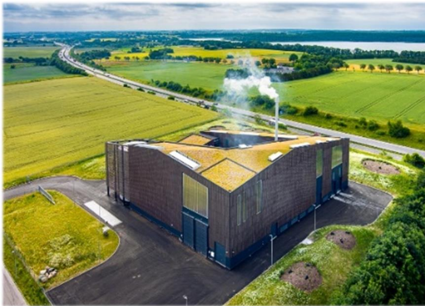
Sorø kraftvarmeanlæg 2021, 12 MWh/1MWE
