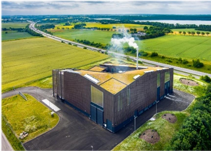
La centrale de cogeneration à Sorø 2021, 12 MWh/1MWE
